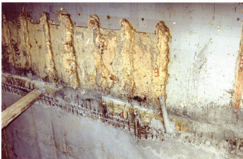
Teatros de S. Luiz e Mário Viegas. Fases do recalçamento de paredes com prévia execução de cortinas de microestacas
