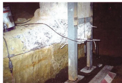
Teatros de S. Luiz e Mário Viegas. Recalçamento dos pilares que suportam a teia e a cobertura
