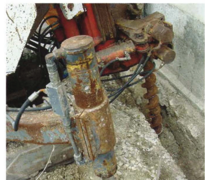
Palácio Pombal. Fase de execução do reforço de fundações da parede da fachada posterior do Palácio com microestacas
