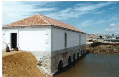
Moinho de Marés do Montijo. Fases de execução de fundações da fachada principal do moinho, com reconstrução do embasamento de pedra
