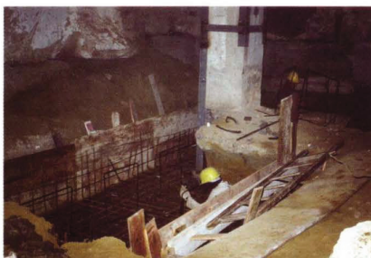
Teatros de S. Luiz e Mário Viegas. Recalçamento dos pilares que suportam a teia e a cobertura
