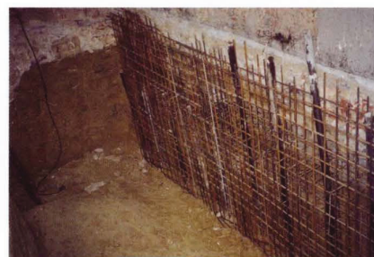
Teatros de S. Luiz e Mário Viegas. Recalçamento dos pilares que suportam a teia e a cobertura
