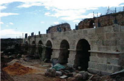
Moinho de Marés do Montijo. Fases de execução de fundações da fachada principal do moinho, com reconstrução do embasamento de pedra
